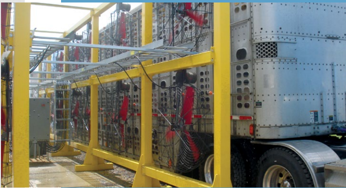
Système combinant la nébulisation et la ventilation. Source : Centre de recherche et de développement de Sherbrooke, AAC
