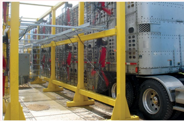
Système de ventilation. Source : Centre de recherche et de développement de Sherbrooke, AAC
