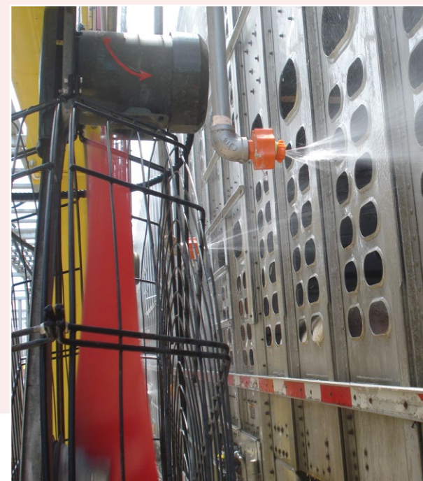
Système combinant l'aspersion et la ventilation. Source : Centre de recherche et de développement de Sherbrooke, AAC
